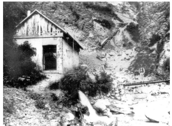
En 1894, la cabane abritant la turbine
