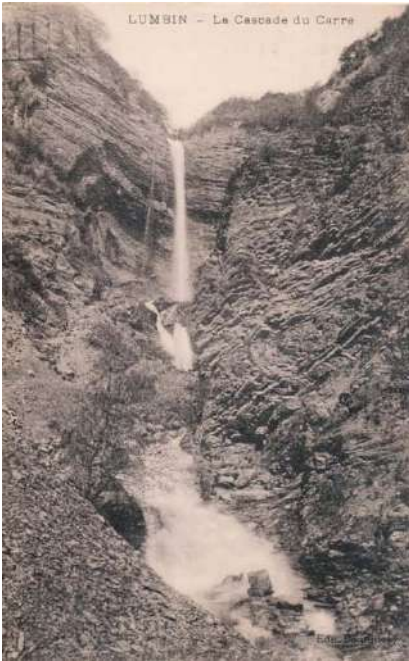
A gauche de la cascade, la conduite forcée sur sa tour
