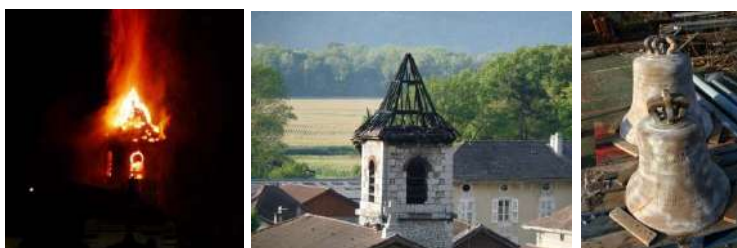
L'incendie, les poutres calcinées et les cloches fendues
