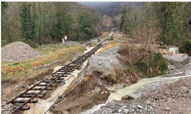
**05** • Nous constatons des dégâts importants également sur les rails du funiculaire. Au moins 250 mètres ne sont plus supportés et se retrouvent « hors sol ». **La nature a rapidement repris ses droits.**
